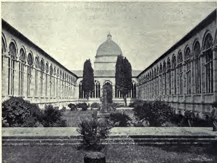
AREA INTERNA DEL CAMPOSANTO.
